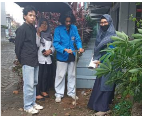
(a) Membuat Lubang Biopori
