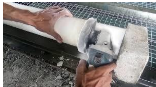
(a) Pemotongan Paralon Menggunakan Alat Gurinda
