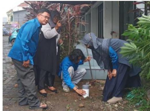
(b) Memasang Paralon Lubang Biopori Gambar 10. Pemasangan Biopori.
