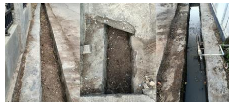
Gambar 5. Kondisi Drainase Setelah Dibersihkan
