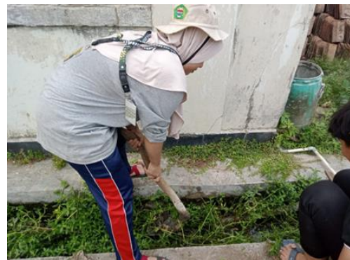
Gambar 4. Pengangkatan Rumput dan Lumpur di Saluran Menggunakan Cangkul
