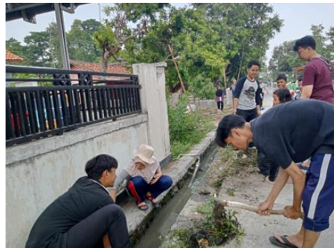
Gambar 3. Proses Pengangkatan Sedimen Lumpur pada Saluran Drainase
