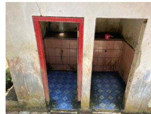
Gambar 3: Kondisi tempat wudhu dan toilet Sumber: Dokumentasi Pengabdian
