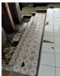
Gambar 7: lantai setelai wudhu dan toilet.
