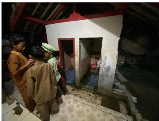
Gambar 2. Kondisi kamar Mandi dan Tempat Wudhu yang masih menyatu
