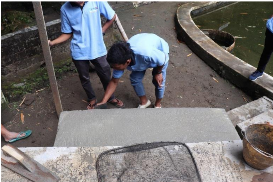
Gambar 1: Pemasangan fasilitas umum berupa kursi taman
