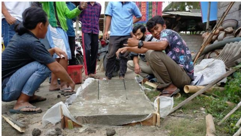
Gambar 4: Pembuatan kursi taman dengan metode cor beton
