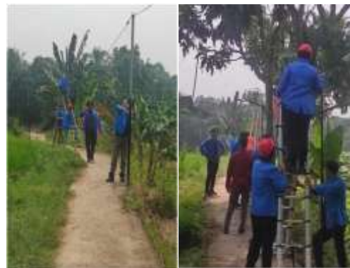
Gambar 4. Proses Pergantian dan Perbaikan PJU
