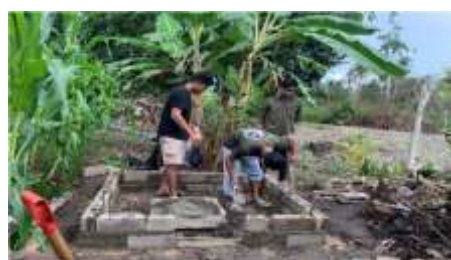
Gambar 6. Pemasangan Batu Bata
