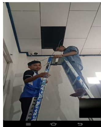
Gambar 1. Kegiatan Instalasi CCTV Kelompok 1
