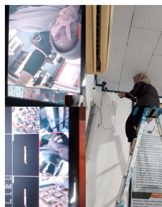
Gambar 2. Kegiatan Instalasi CCTV Kelompok 2
