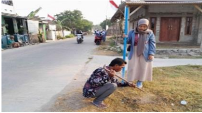
Gambar 2. Pemasangan Plang Nama Lingkungan
