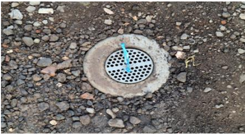
Gambar 4. Monitoring dan Evaluasi Pemasangan Biopori pada Pawon Urip
