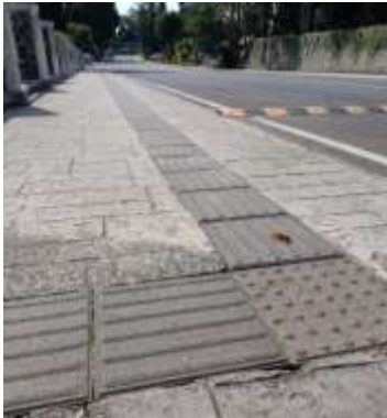
Gambar 2. Fasilitas Aksesibilitas Difabel di Area Luar Gedung UPI
